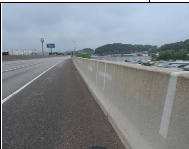
내 용 S2 방호벽 전경
