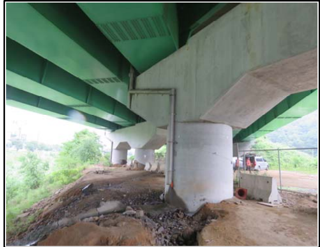
내 용 S2 배수관 전경
