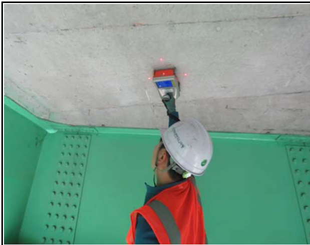
내 용 바닥판하면 철근탐사
