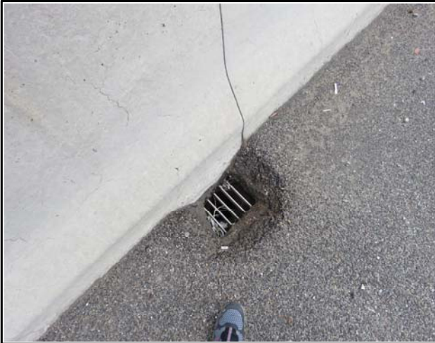
내 용 S3 배수구 상태양호
