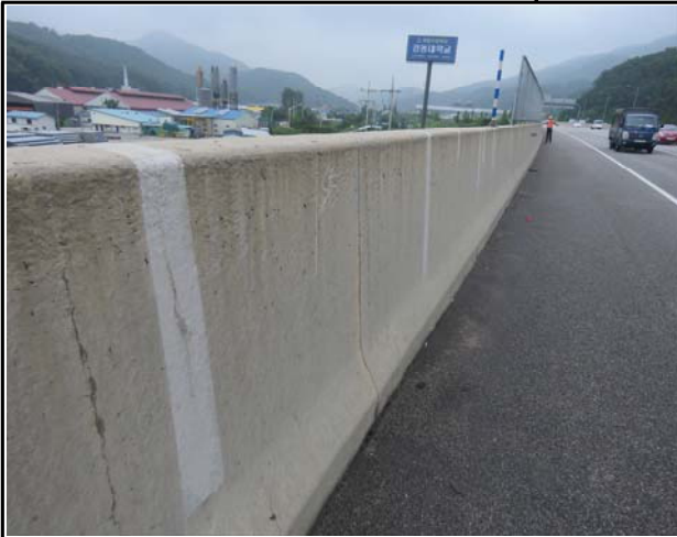
내 용 S1 방호벽 전경
