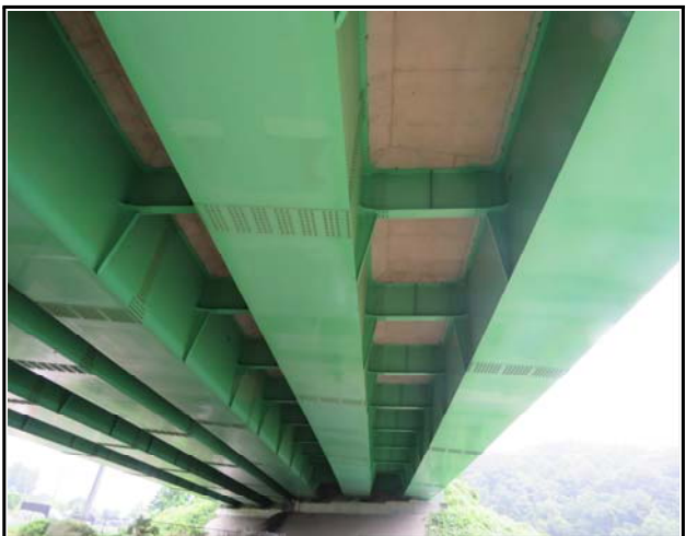
내 용 바닥판하면 전경
