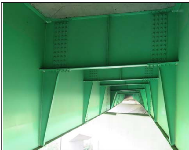
내 용 바닥판 가로보 전경
