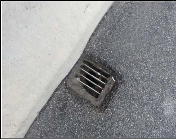
내 용 S1배수구 상태양호
