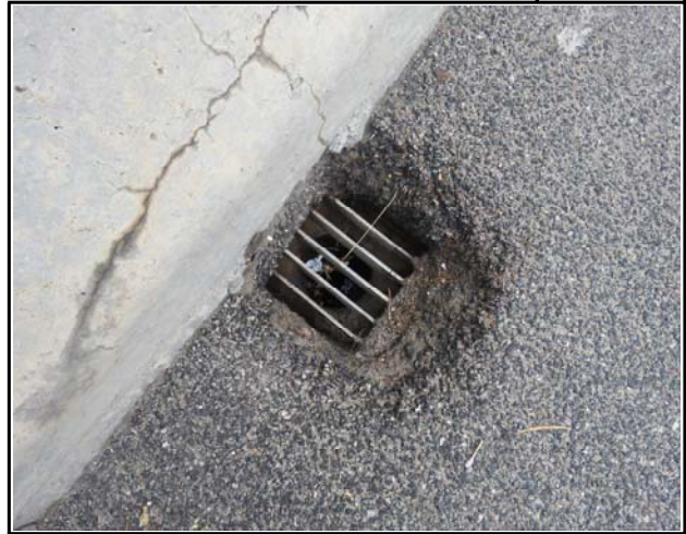
내 용 S2 배수구 상태양호
