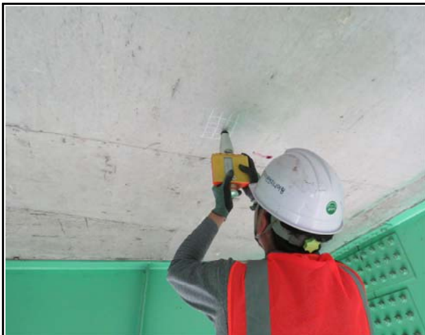
내 용 바닥판하면 콘크리트 강도실험
