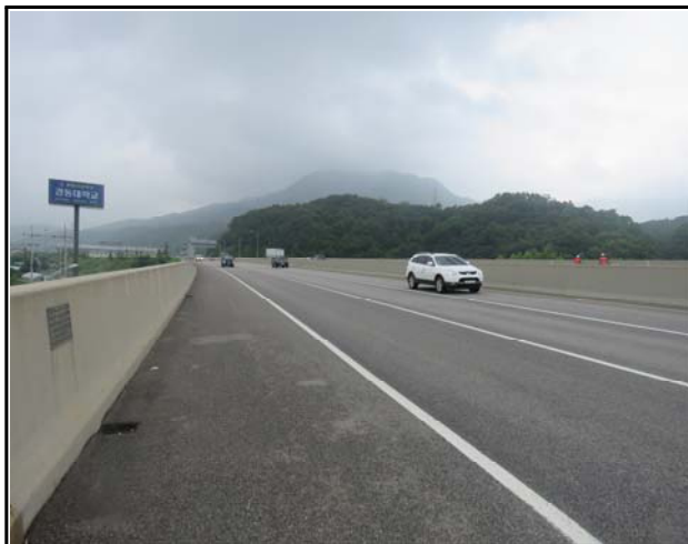
내 용 교면포장 전경
