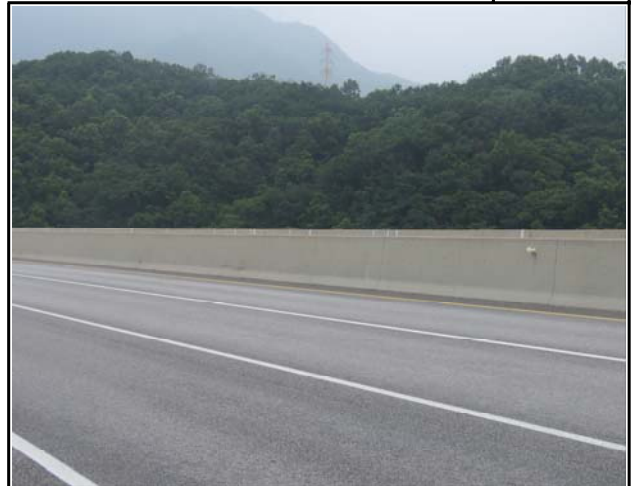
내 용 S1 중앙분리대 전경
