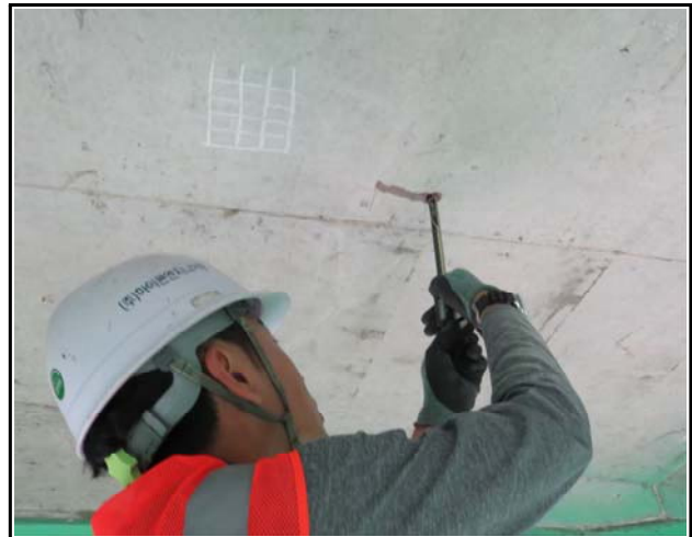
내 용 바닥판하면 탄산화 깊이측정
